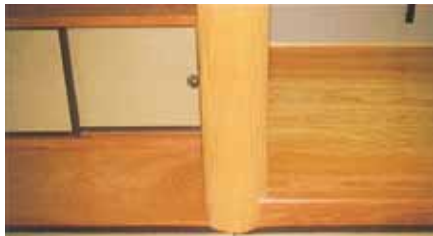
松貼床前板、床板
